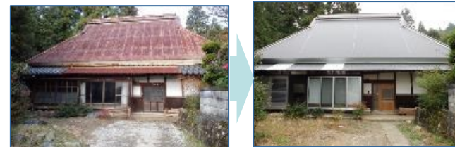
地域活性化のため、空き家を地域交流施設に活用
