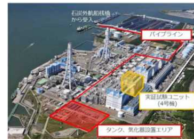
アンモニア混焼実証事業が行われる 愛知県碧南火力発電所
