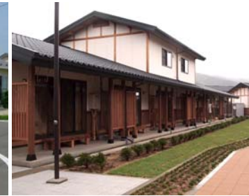
大槌町災害公営住宅
