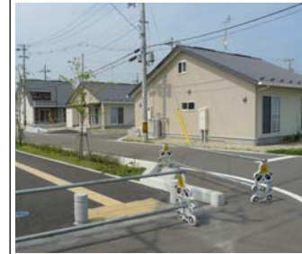
山元町災害公営住宅
