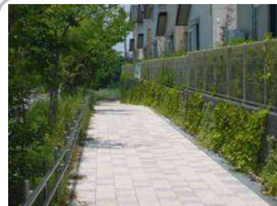
壁面緑化と遮熱透水舗装
