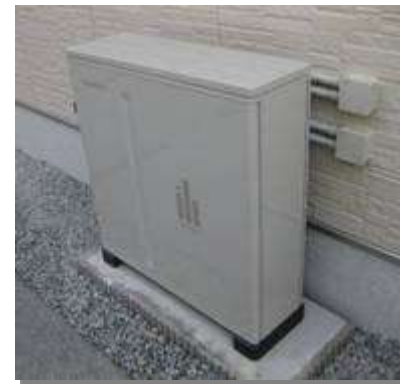
リチウムイオン蓄電池
