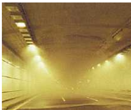
水噴霧設備 (トンネル等)
